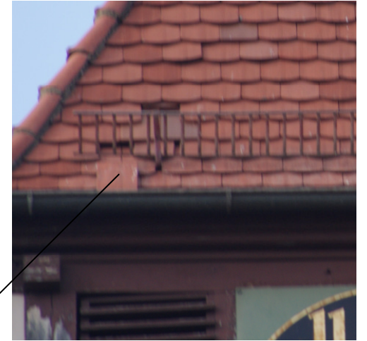
Turmziegel Sturmsicherung
