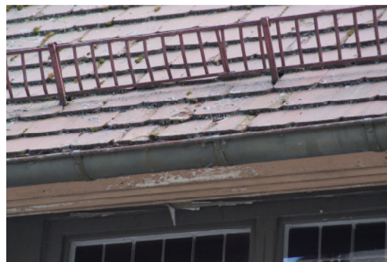
Kirchendach: Nord- und Südseite Ziegel erneuern und Wärmedämmung
