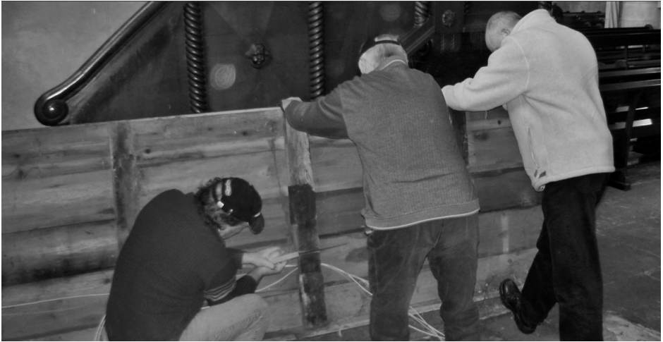
Die alten Holzböden werden entfernt
